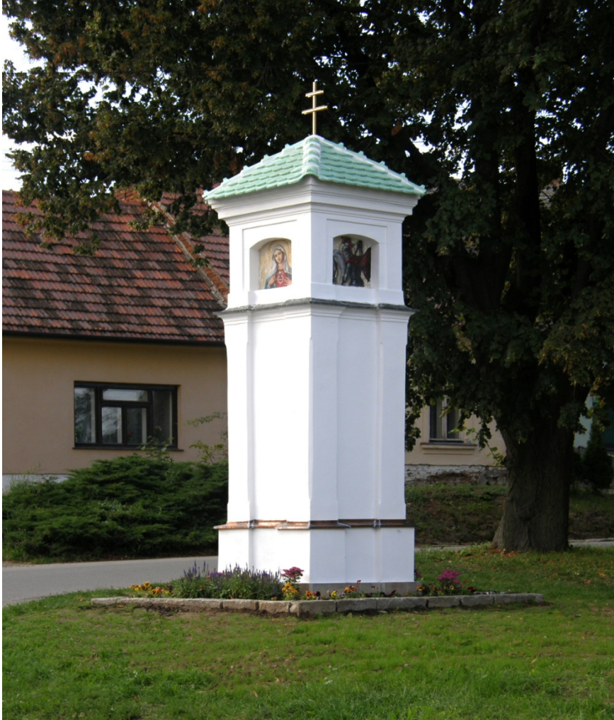
Boží muka na ulici Ježkov po rekonstrukci
